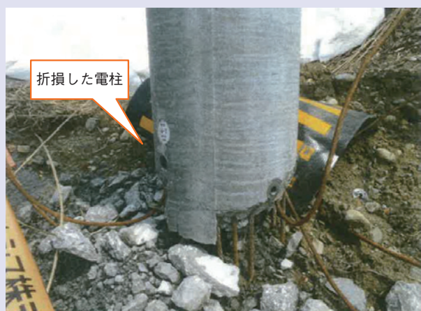
図1 雪害により傾斜した電柱の様子（新潟県長岡市）
