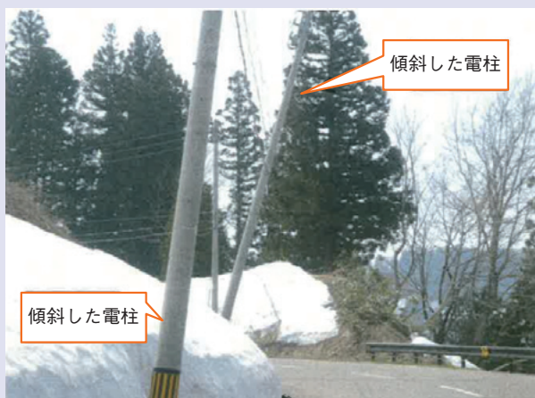
図1 雪害により傾斜した電柱の様子（新潟県長岡市）
