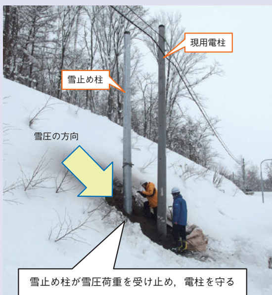
図2 現用電柱に対する、雪止め柱の適用トライアル(北海道旭川市)
