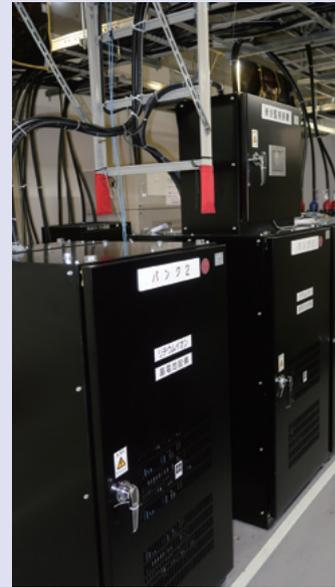
図5 HVDC用リチウムイオン電池
