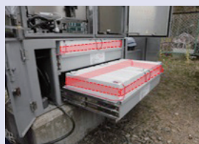
(b) RSBM-F (屋外設置型)「忌避テープ」設置状況
