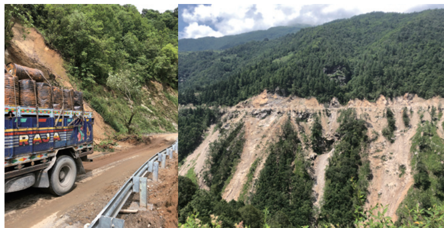
写真1 Thimphu～Trongsa間国道メインルート
