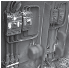
引込盤の焼損
