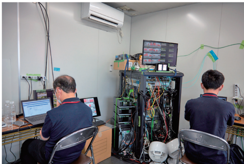
図7 超低遅延通信技術を提供したNTTのネットワーク設備
