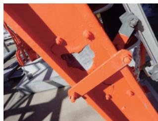
②塗装工事後の腐食事例
