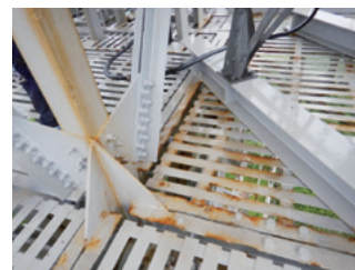
図2 鉄塔の劣化事例
