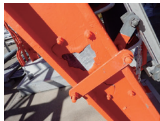
図2 鉄塔の劣化事例
