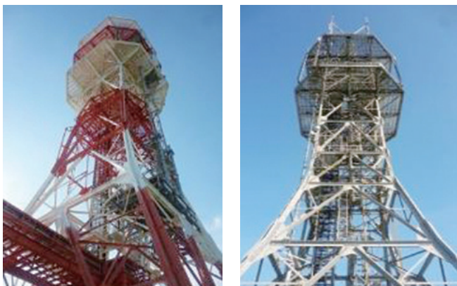
図1 鉄塔の全景写真
