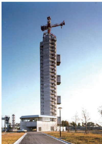
(a) 竣工時の外観 (1983年)
