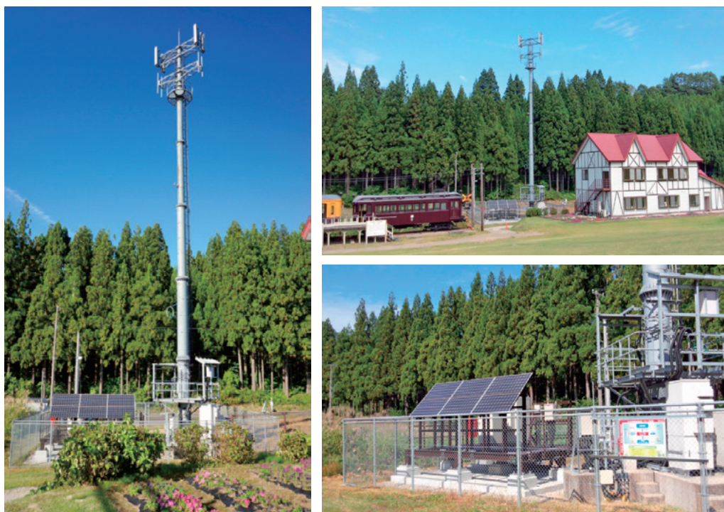
図1 グリーン基地局の開発導入事例
