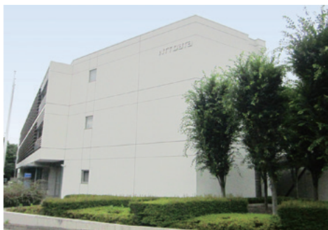
写真1 駒場研修センター外観
