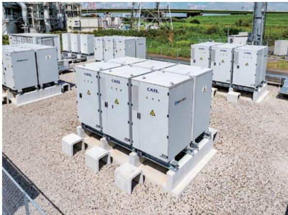
図3 系統蓄電池の一例(NTTアノードエナジー 和光蓄電所)
